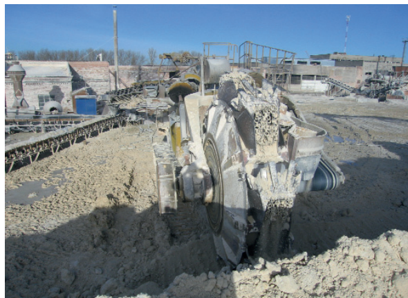
Bild 1 Abtragung der aufgebauten Roherdehalde für die Produktion
